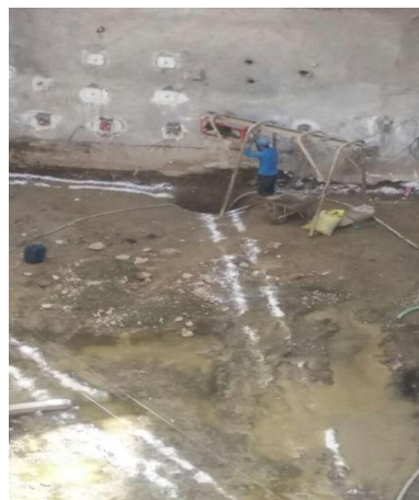
حفر چاه های زهکشی در ضلع شمال و جنوب
