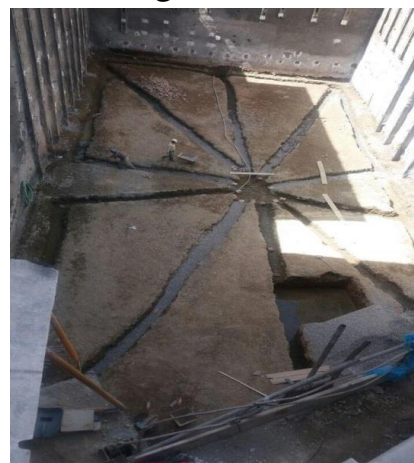
رگلاژ و شیب بندی کف
