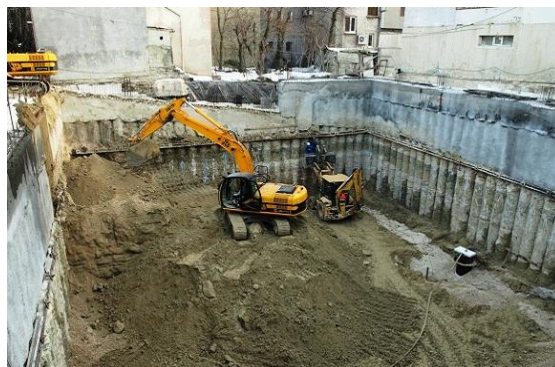
شکل ۲-۱۱- نمونه‌ای از پایدارسازی آب‌بند به روش شمع‌های سکانت (تودرتو)
