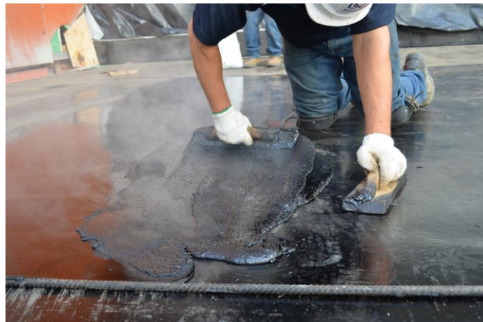
شکل ۲-۷- استفاده از آسفالت ماستیک در پی سازه
