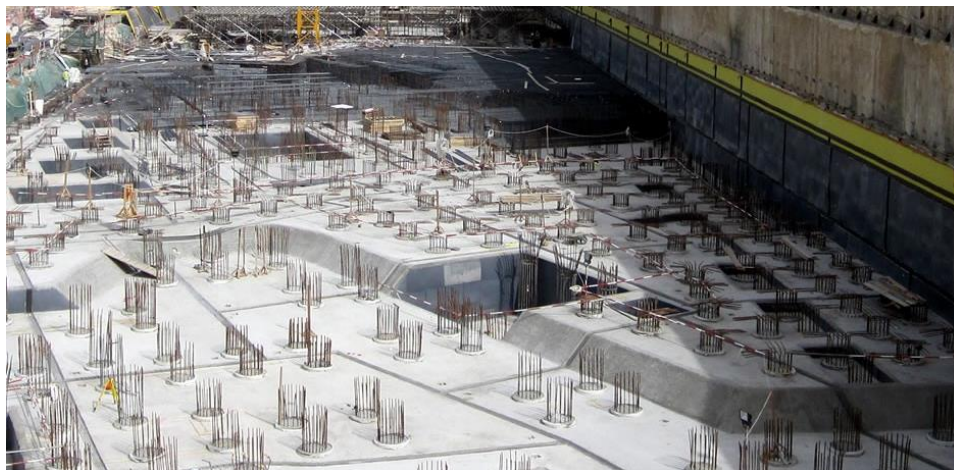
شکل ۲-۸- استفاده از GCL در پی سازه
