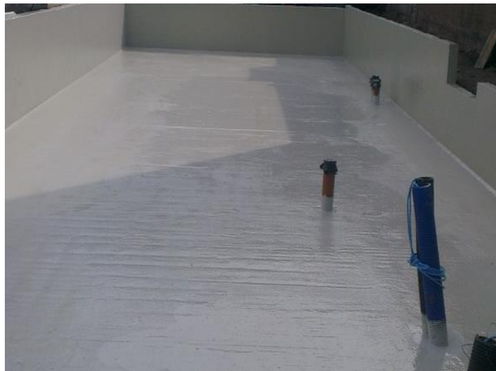
شکل ۱۰-۲- استفاده از مواد پایه سیمانی چند لایه در پی سازه
