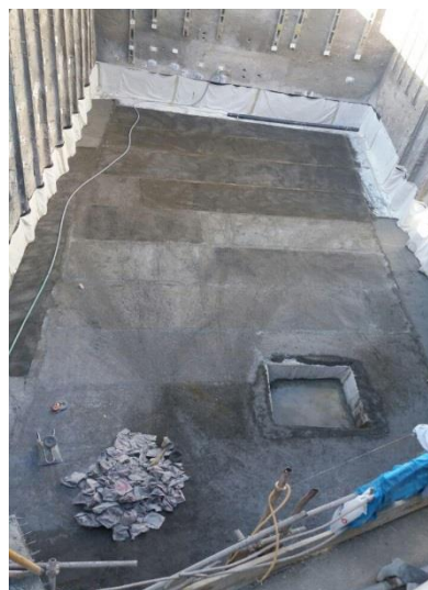
اجرای بتن لایه دوم بتن مگر
