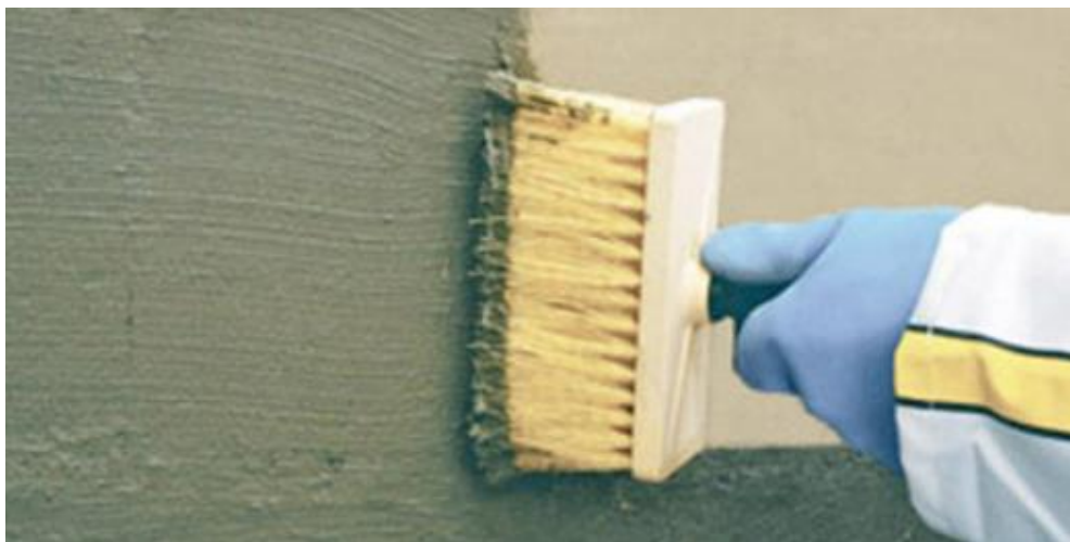
شکل ۲-۹- استفاده از مواد کریستالی شونده در پی سازه
