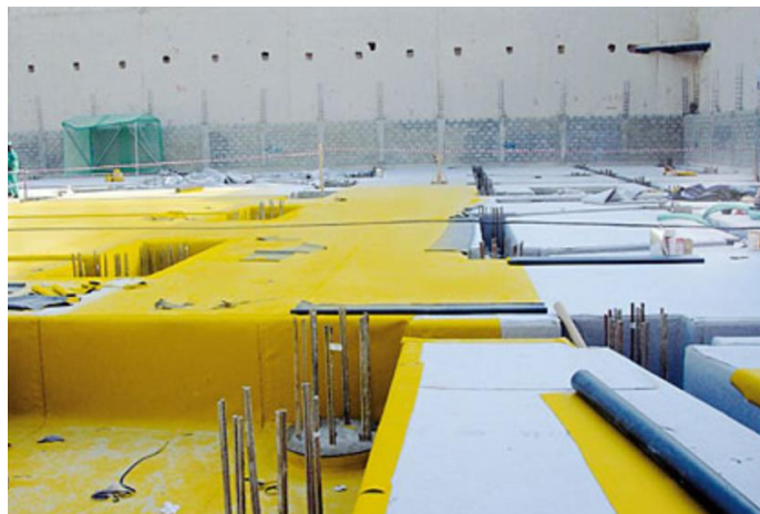
شکل ۲-۵- استفاده از ژئوممبران PVC در پی سازه‌ها
