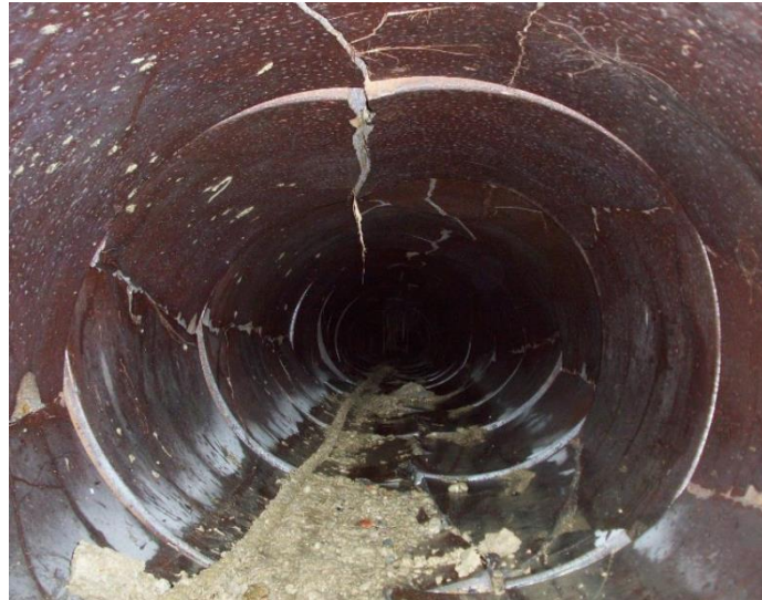
شکل ۴-۵- نمایی از شکستگی کانال زهکش
