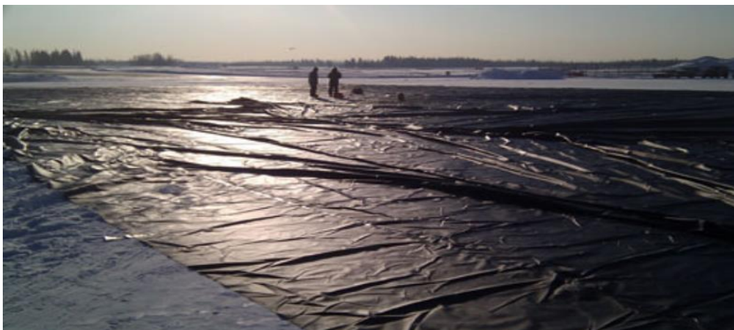
شکل ۲-۴- چین و چروک انبساطی در اثر تغییرات دما روی ژئوممبران HDPE
