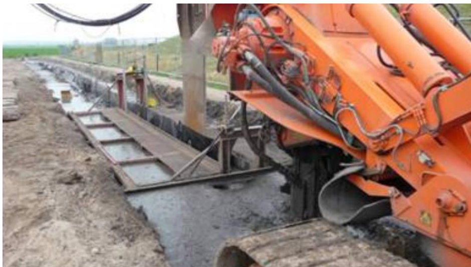
شکل ۲-۱۲- پرده آب‌بند به روش برش قالبی خاک
