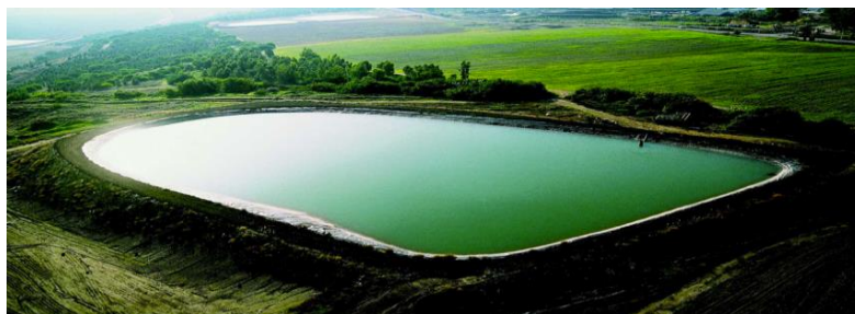
شکل ۲-۳- استفاده از ژئوممبران HDPE در مخازن ذخیره آب کشاورزی
