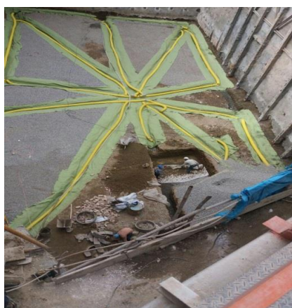
استفاده از لوله های زهکشی و شن ریزی کانالها
