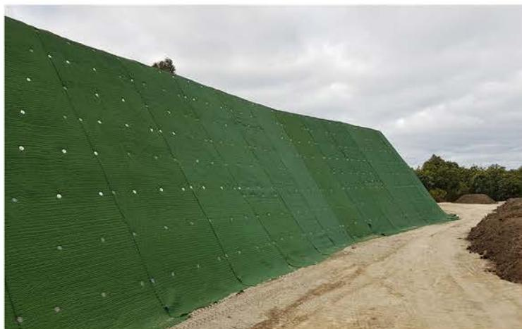
از دیگر اثرات پیشگیرانه مصالح ژئوپلستیک در کنترل فرسایش میتوان به کاربردهای اصولی زهکشی و فیلتراسیون این مصالح در جلوگیری از رخداد زمین لغزش‌ها، آبسستگی، روانگرایی، اختلال در زهکشی و ... اشاره نمود.
